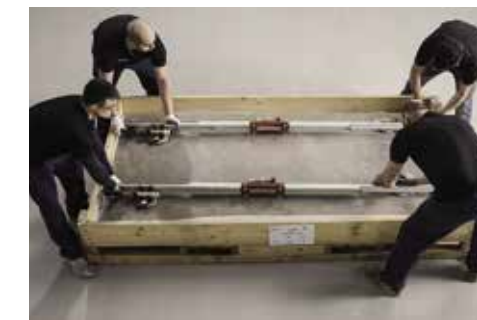
La movimentazione al piano può essere gestita con l'ausilio di un telaio provvisto di ventose per conferire una maggiore stabilità alla lastra.
