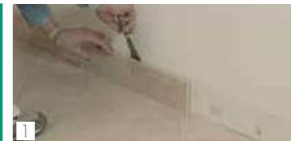
1 Eliminare il battiscopa Remove skirting
