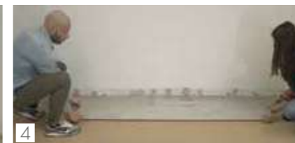
4 Posare il pavimento senza fuga Lay the floor tiles with close joints
