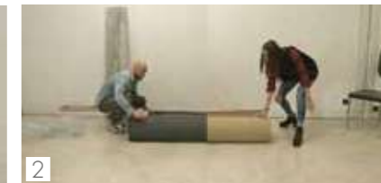
2 Stendere il tappetino Lay the underlayer
