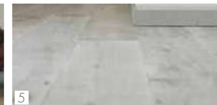
5 La superficie risulterà perfettamente planare The finished floor will be perfectly flat
