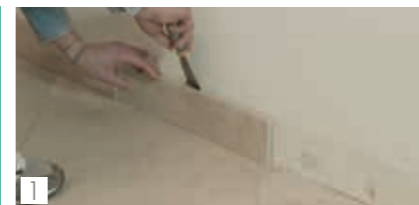
1 Eliminare il battiscopa Remove skirting
