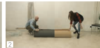
2 Stendere il tappetino Lay the underlayer
