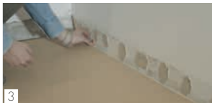
3 Posizionare i distanziali lungo il perimetro Fit the spacers around the outer edge
