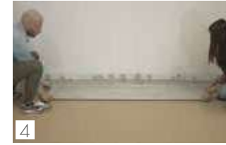
1 Eliminare il battiscopa Remove skirting
